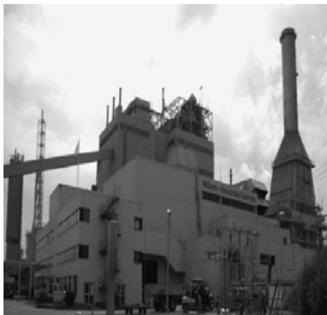
Εικόνα 4. Το εργοστάσιο στο Buggenum (Γερμανία) με Εξαεριωτήρα Εξαναγκασμένης ροής βιομάζας Παραγωγής ρεύματος Ισχύος 253 MW Καταναλώνει κοπριά κοτόπουλου αναμεμιγμένη με άνθρακα
