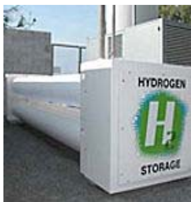
Εικόνα 30. Αποθηκευτικός κύλινδρος πεπιεσμένου υδρογόνου (σχεδιάγραμμα εγκατάστασης)
