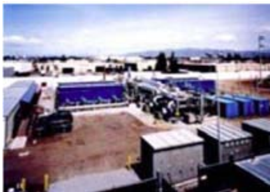
Εικόνα 53. Μονάδα με 16 συστοιχίες MCFC ισχύος 2MW santa Clara California
