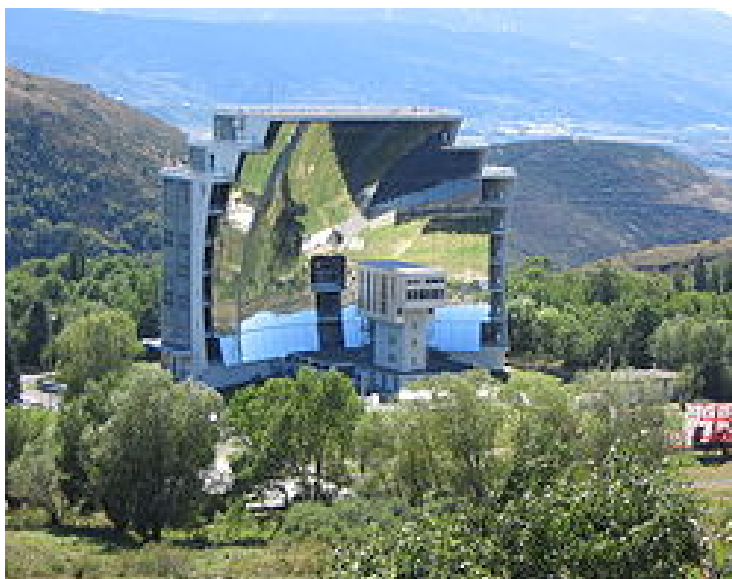
Εικόνα 7. Γαλλία, διάταξη ηλιακού συλλέκτη, μέγιστη θερμοκρασία 3800°C
